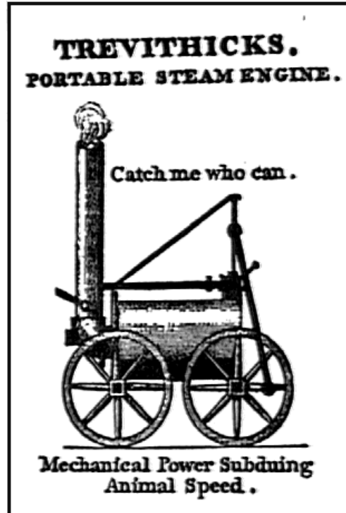
Fig. 1. 'Que me coja el que pueda'. Richard Trevithick en 1804 desarrolló la primera locomotora (para una mina en Gales), pero destrozaba las vías de madera y fue destinada a mover un eje sin moverse de sitio.
